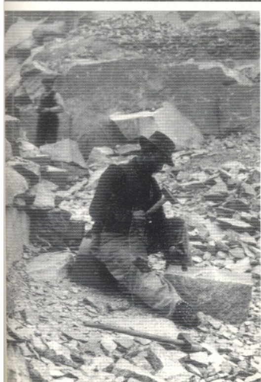
IZQUIERDA: Picapedrero «cortador». Está «rayando» la cara superior del bloque con el scarpel, para reducirlo luego a adoquines. Obsérvese la suela del botín, claveteada de «brocas» para no resbalar sobre la piedra y evitar el desgaste.
