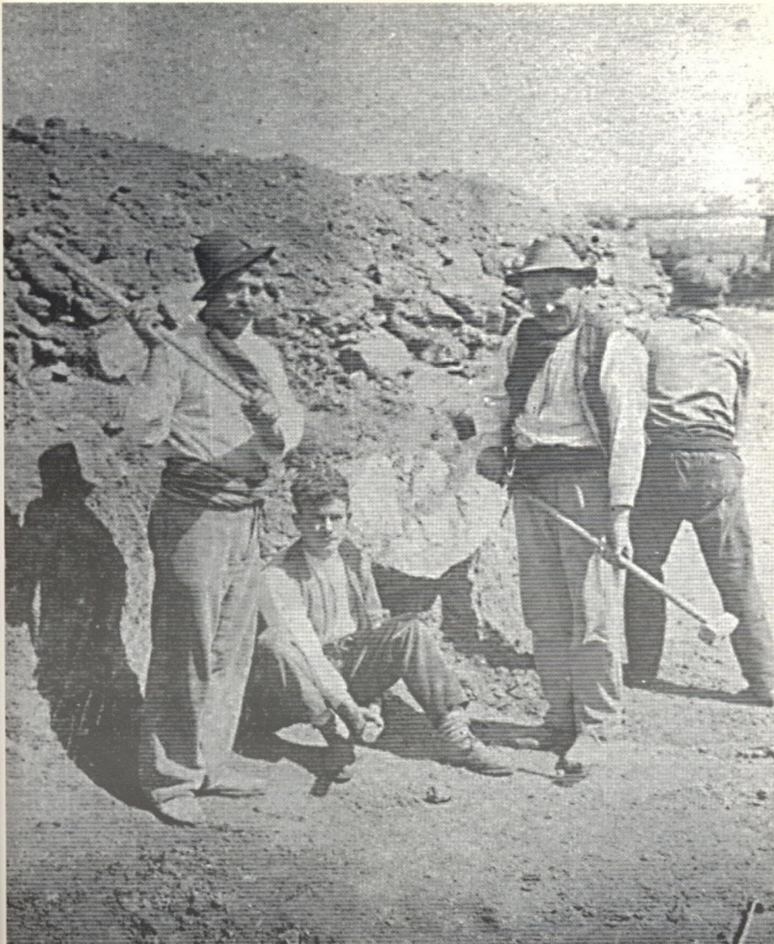
Una cubia de barrenistas interrumpe momentánea la tarea, mientras abre un barreno de levante. El que está sentado sostiene con su mano derecha el barreno, que sus dos compañeros golpean alternativamente. El que lo sostiene hace girar un cuarto de vuelta al barreno tras cada golpe. Los hombres se alternaban en la tarea mientras el acero iba penetrando lentamente en la piedra.
